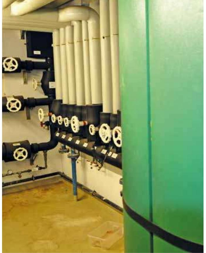
Die Trinkwasserspeicher werden nicht von einem Energiemanagement angesteuert. Sie entnehmen sich die notwendige Wärme aus dem zentralen Verteiler. Da sie ohnehin den beiden XRGIs beinahe die gesamte Leistung abnehmen, durfte eine aufwendigere Regelung entfallen.
