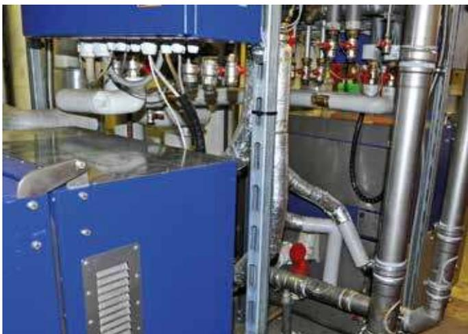
Normalerweise gehört zu den XRGI-Einheiten ein Wärmeverteilungsmodul. Ein solches zu installieren gestatteten die Verhältnisse im Caritas-Haus nicht. Die Anlagenbauer mussten sozusagen in Handarbeit die beiden Einheiten an den Wärmeverteiler anschließen.
