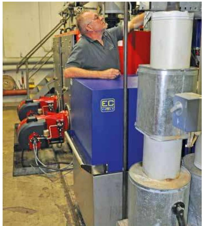
Block 1 der Zweier-XRGI-Kaskade mit je 15 kW elektrisch und 30 kW thermisch. Die beiden verbliebenen Ölkessel à 500 kW müssen in der Sommerzeit maximal in den frühen Morgenstunden oder abends den XRGI-Maschinen zur Warmwasserbereitung zur Seite stehen.
